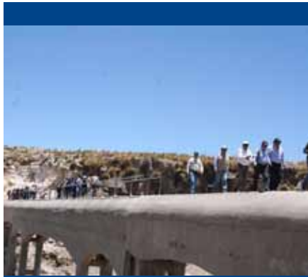
Prueba hidráulica de irrigación en el cañón de Apurímac
